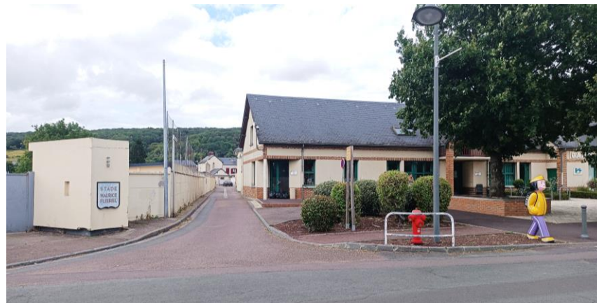
Poteau incendie installé au niveau des équipements communaux à Romilly-sur-Andelle. Source : GAMA Environnement
