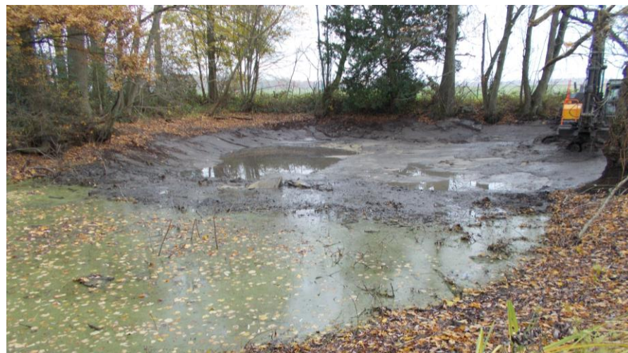
Travaux de réhabilitation d'une mare sur la commune de Bacqueville dans le but de favoriser l'infiltration des eaux pluviales et de restaurer ce réservoir de biodiversité. Source : SYMA
