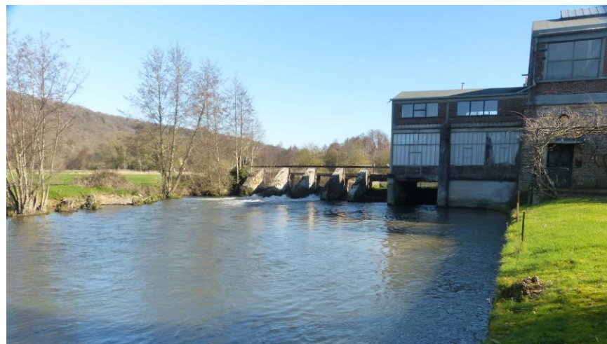
Le barrage du moulin de Bacqueville à Pont-Saint-Pierre en mars 2022. Source : SYMA
