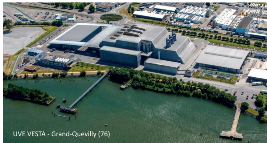
L'unité de valorisation énergétique située à Grand-Quevilly. Source : RPQS 2021 SYGOM
