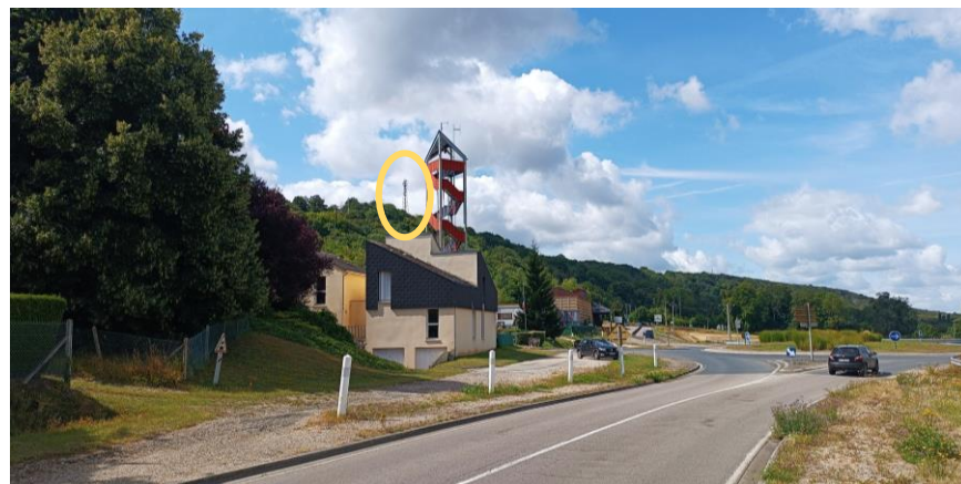
Antenne téléphonique située au-dessus de la côte de Grainville visible depuis la RD 321 derrière le SDIS de Fleury-sur-Andelle. Source : GAMA Environnement
