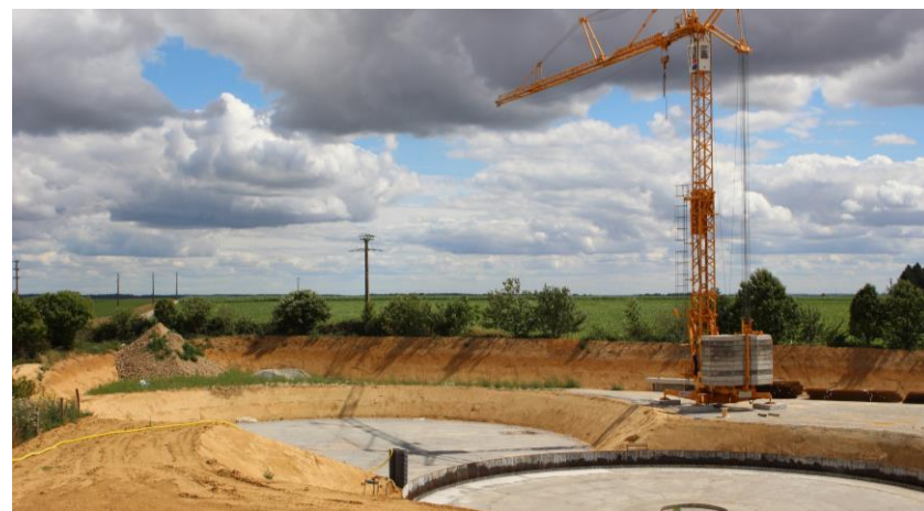
Unité de méthanisation en construction à la ferme des Peupliers à Flipou.
