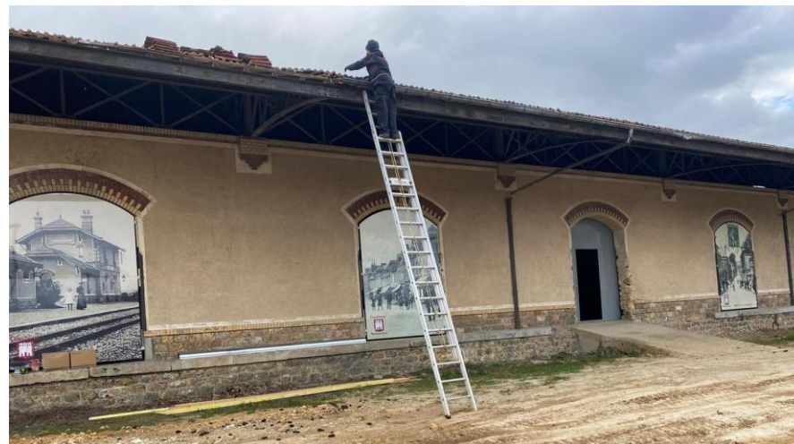
Réhabilitation de l'ancienne halle SNCF de Charleval en maison des associations. Source : L'impartial
